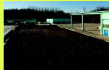
La biofiltrazione è una tecnologia mediante la quale le emissioni gassose da trattare vengono fatte passare uniformemente attraverso un mezzo poroso biologicamente attivo, ovvero in un apposito letto riempito con materiale lignocellulosico, mantenuto in idonee condizioni di temperatura e umidità.
