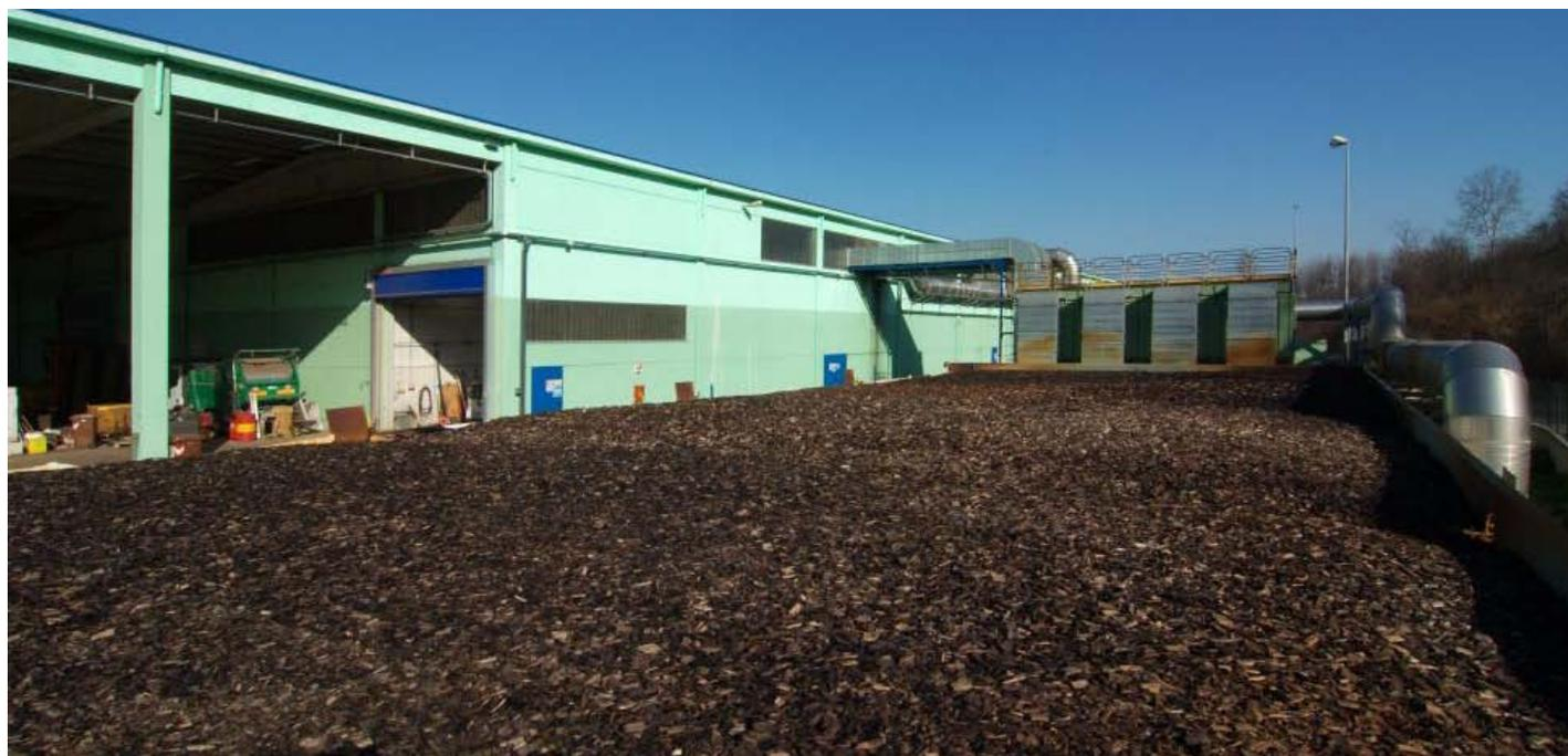
[Figura 52.]: Veduta del biofiltro 1 dell'impianto di compostaggio di GAIA SpA a San Damiano d' Asti
